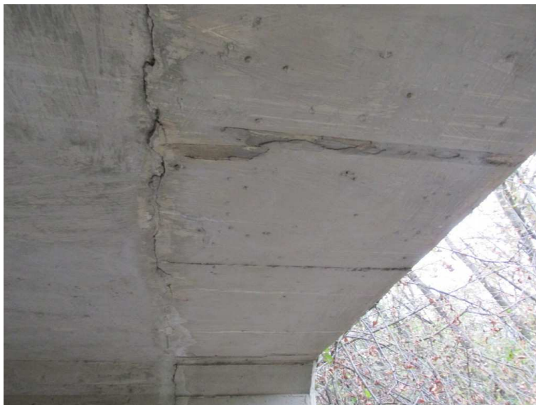
22) NK – pohled vpravo - dobetonávka
