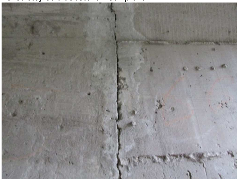
23) NK – detail mezi rámovou stojkou a dobetonávkou vpravo
