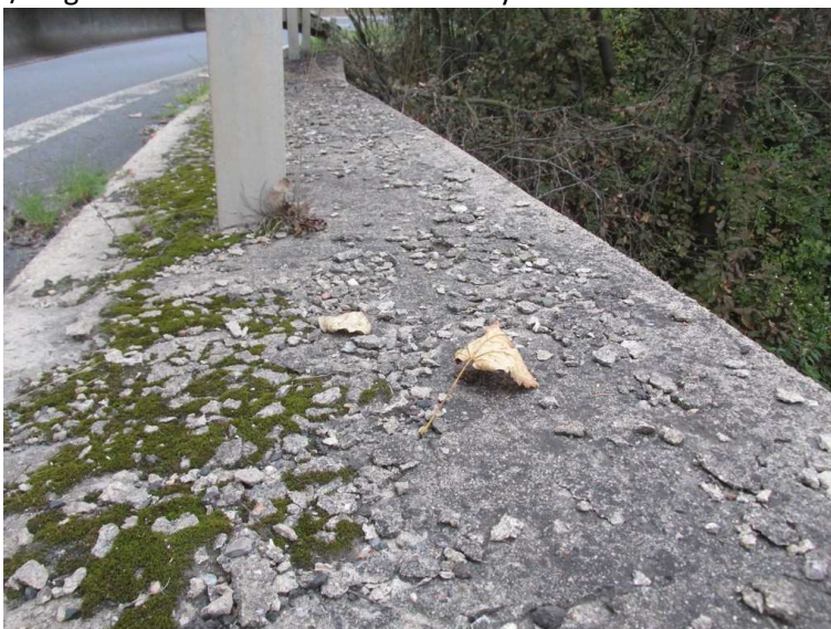
33) Detail římsy vpravo / degradace betonu horního líce římsy
