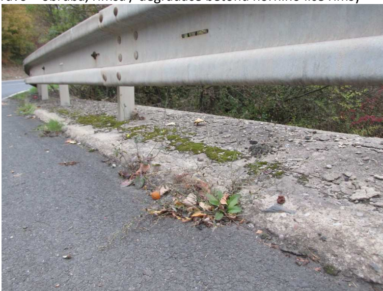
32) Detail k vozovce vpravo – obruba, římsa / degradace betonu horního líce římsy
